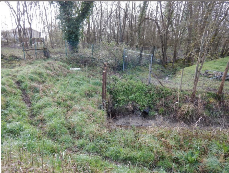
Figure 5. Ouvrage hydraulique actuel
