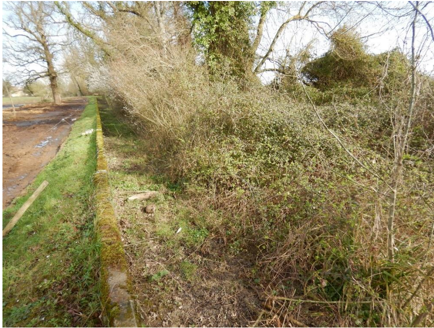
Figure 17. Vue générale de la digue à démolir sur quelques mètres pour passage de la canalisation
