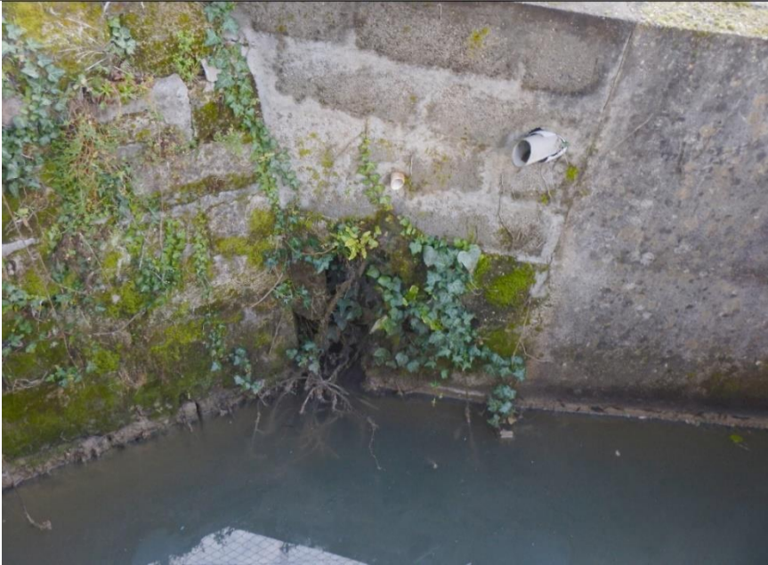
Figure 9. Fissures importantes dans le bâti
