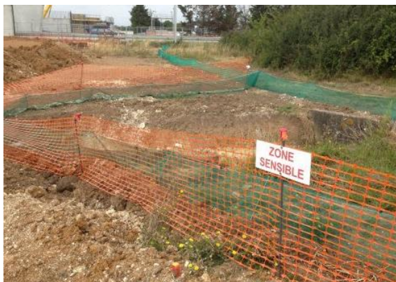
Figure 45. Exemple de filets anti-amphibiens (source : Vinci)
