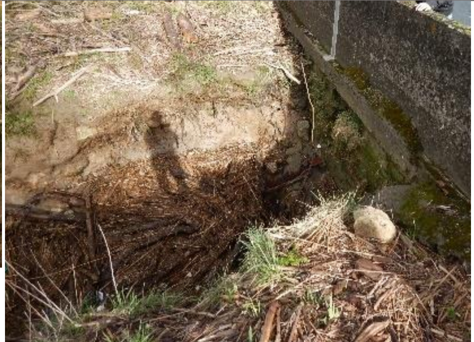
Figure 4. Sortie de la buse avec clapet
