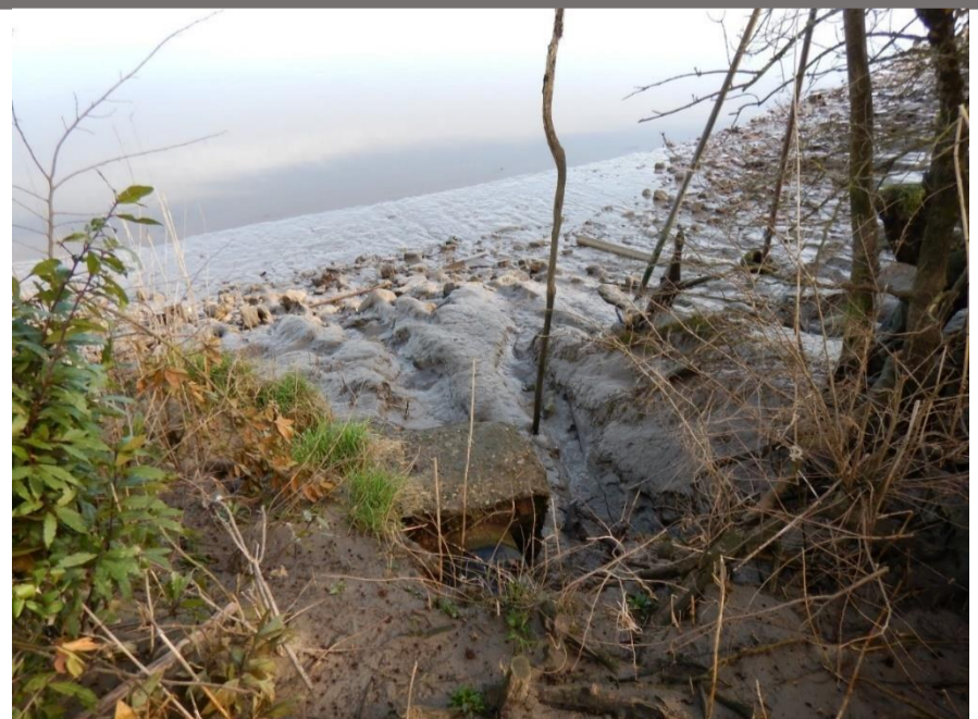
Figure 8. Sortie de buse avec clapet
