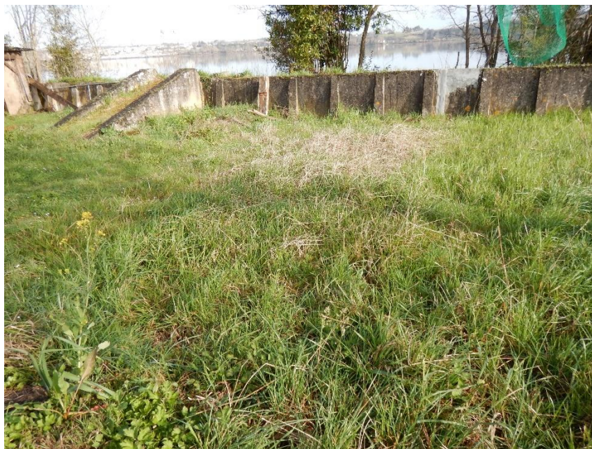
Figure 15. Digue béton à trouser pour passage de la canalisation
