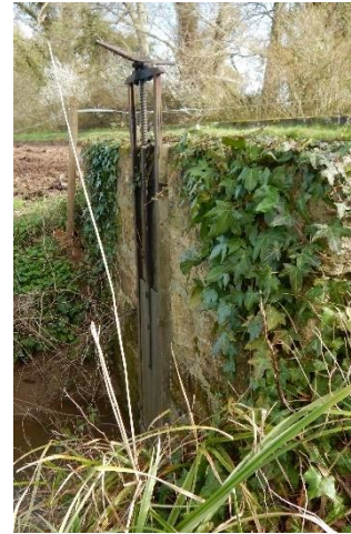
Figure 20. Pelle à remplacer
