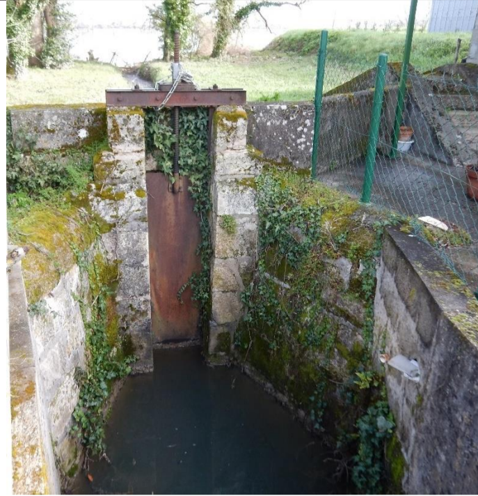
Figure 10. Pelle à remplacer
