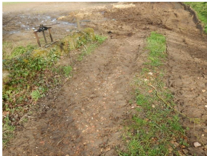
Figure 18. Chemin à ouvrir pour passage de la canalisation
