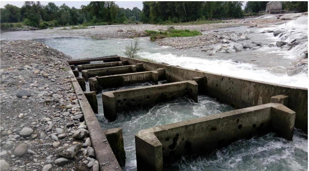
Les matériaux qui ont été retirés des bassins ont été mis en place le long du bajoyer gauche de la passe. Le volume n'excédait pas 10 m<sup>3</sup>. Ces matériaux ont servi à combler l'espace qui existait entre la berge et le pied de la passe à poissons (cf. photo suivante avant intervention).
