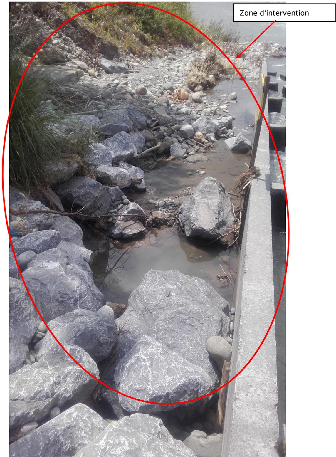
Figure 4: Photographie de la zone d'intervention – enrochement soutenant le bajoyer gauche de la passe à poissons
