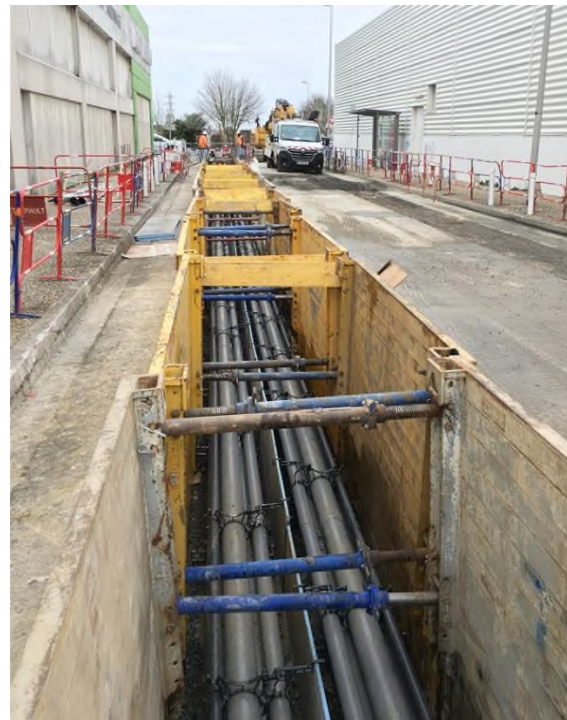
Photo 9 : Pose de fourreaux PVC bétonnés en double ligne (avenue d'Italie à Puilboreau)
