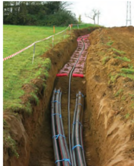
Photo 8 : Exemple de pose de fourreaux PEHD en pleine terre
