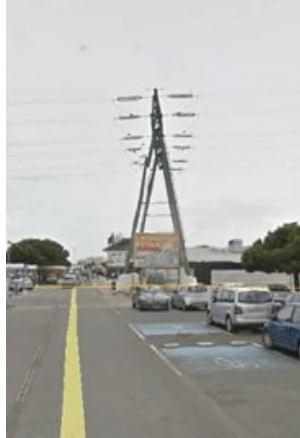
Photo 2 : Pylône « Trianon » de profil
