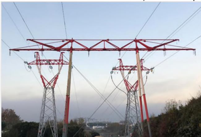
Photo 4 : Remplacement du pylône Trianon n°11 par deux pylônes treillis à Lagord
