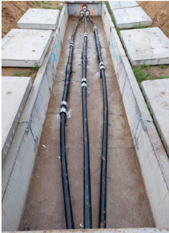
Photo 7 : Exemples de chambres de jonction
