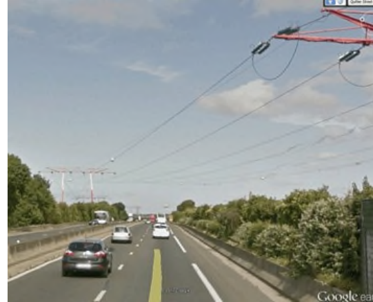
Photo 3 : Pylônes « Trianon » 10 et 11
