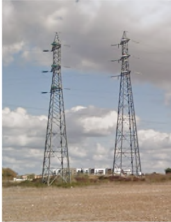
Photo 1 : Pylône « Treillis » à Beaulieu
