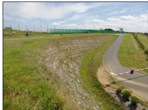
Photo 18 : Berme routière en arrière de la falaise
