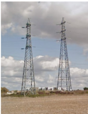
Photo 10 : Pylône « Treillis » à Beaulieu
