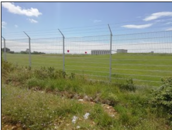
Photo 25 : Site de l'aéroport
