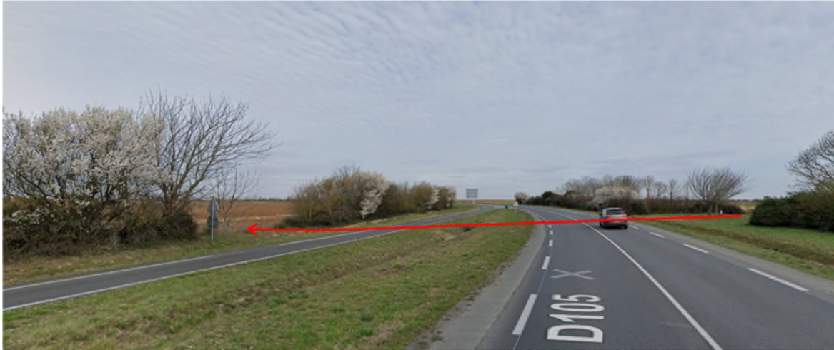
Vue 9 - Traversée par fonçage de la RD105 depuis le chemin des Sableaux (Lagord)
