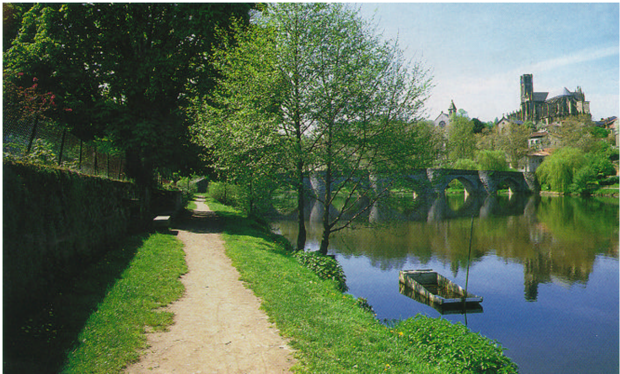
Le pont Saint-Etienne (XIII e s.) sur le Vienne. (Ph. G. Simonneau)
