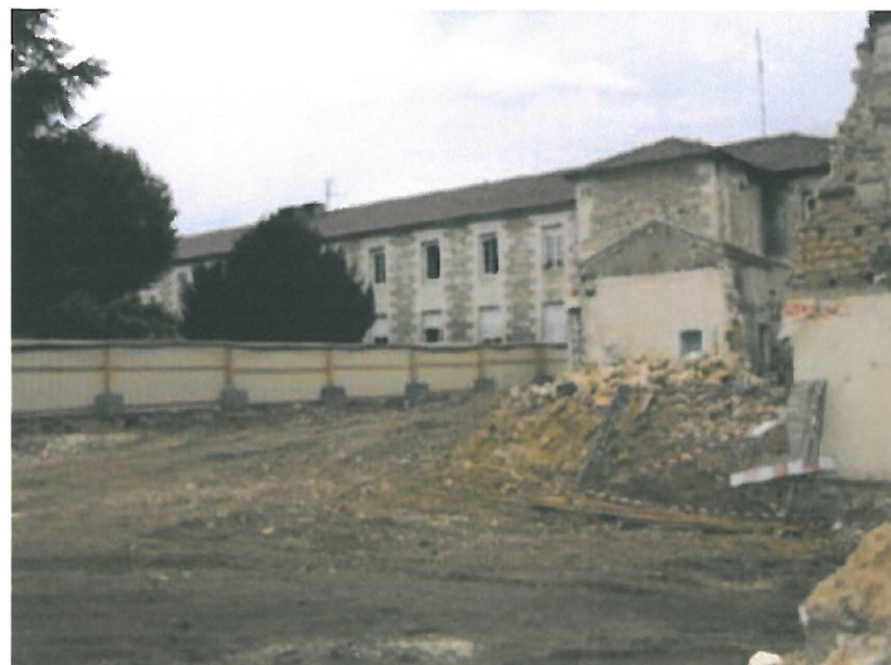
Photos 2012 (après démolition partielle)
