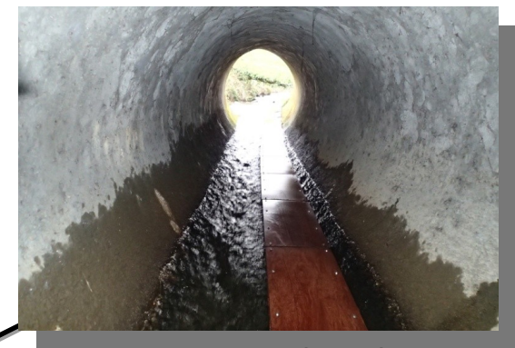
N162 en Mayenne (2016). R au des Haies (85 m)
