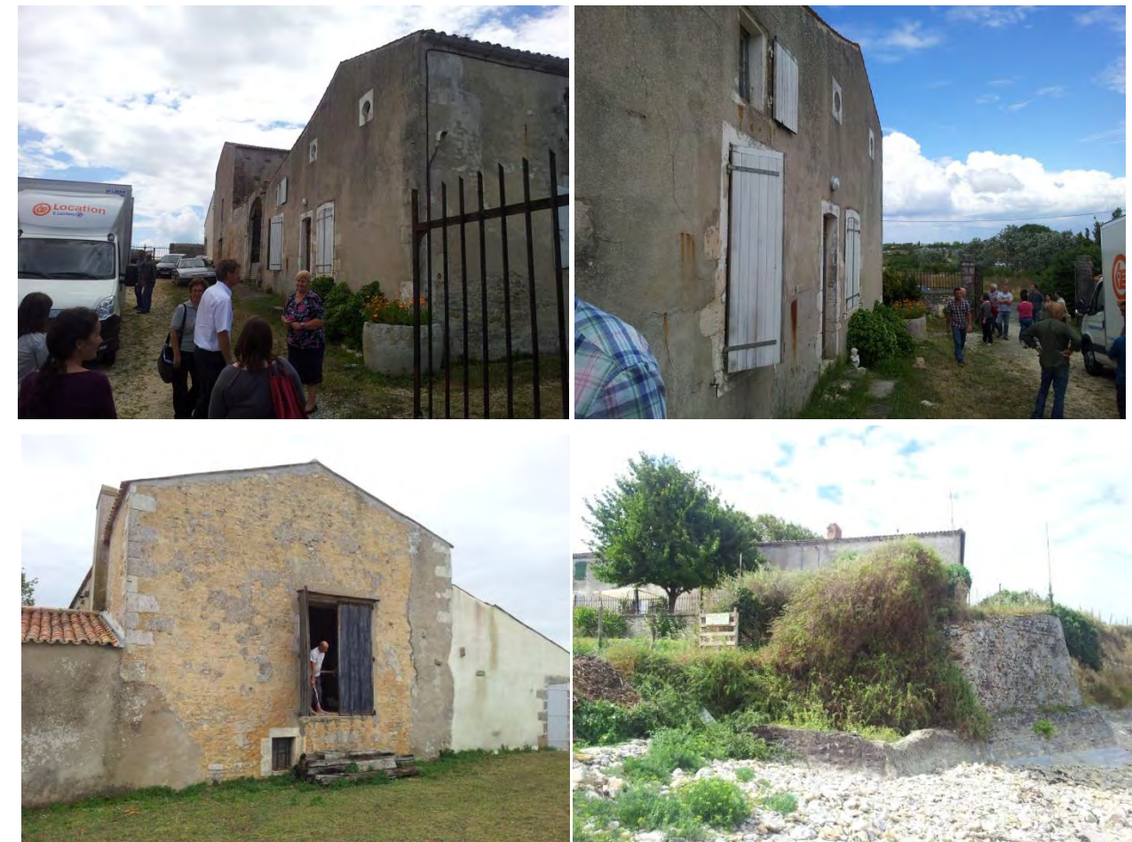
Figure 30 : Illustration photographique de la Ferme du Rocher existante
