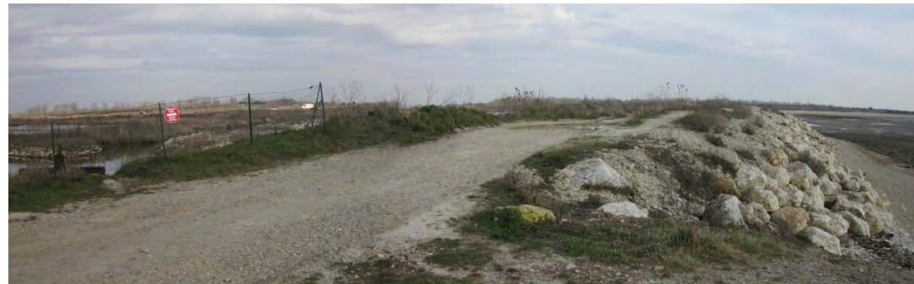
Figure 19 : la digue existante, vue du Nord vers le Sud
