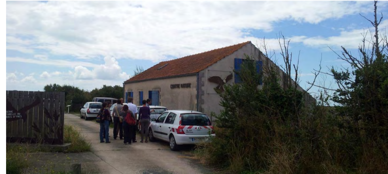
Figure 29 : le Centre Nature existant, déconstruit dans l'aménagement de la digue
