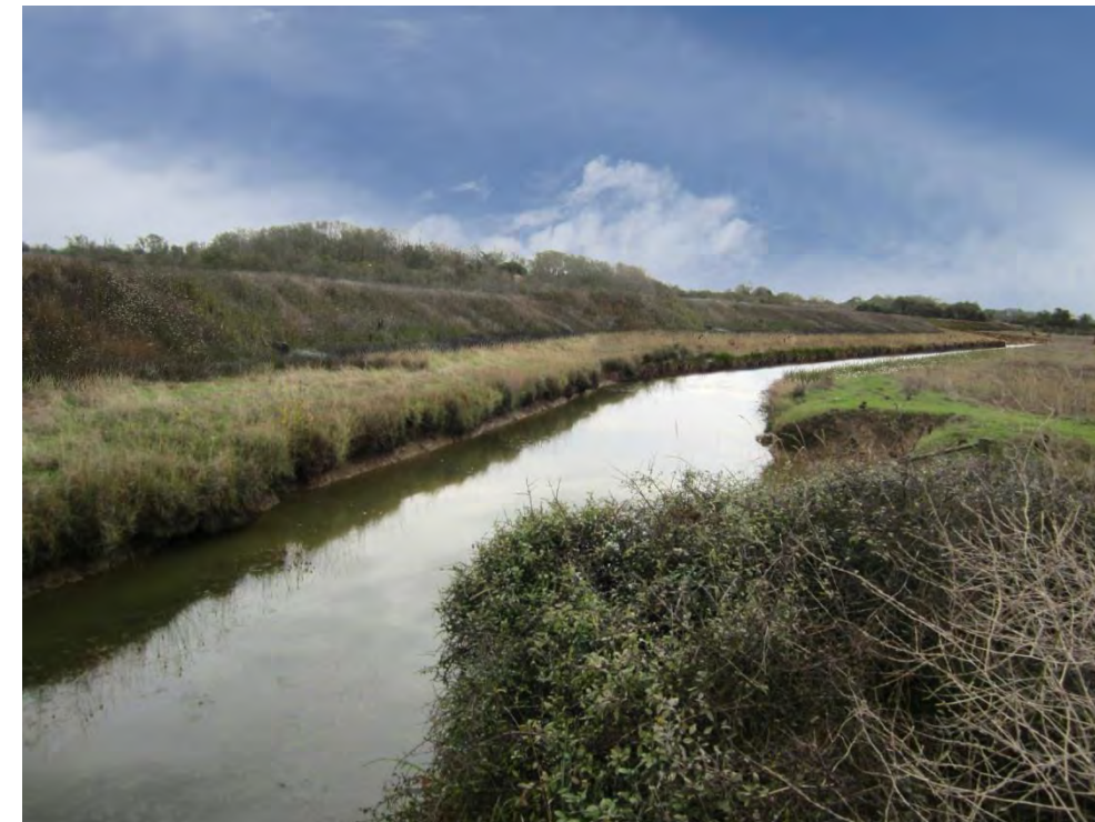
Vue après végétalisation de la digue – prairie le long du fossé syndical dans la zone de franchissement par la digue – mois d'octobre : Déviation de l'étier
