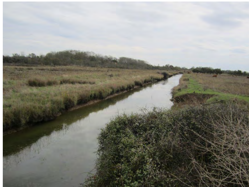
Vue avant travaux – prairie le long du fossé syndical dans la zone de franchissement par la digue – mois d'octobre
