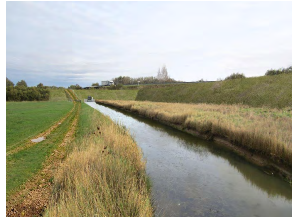
Vue après végétalisation de la digue – Angle du fossé syndical et de la RD137 (talus routier) – mois d'octobre : Déviation de l'étier et ouvrage de gestion (cadre avec vanne) + rampe de franchissement pour engin agricole et bétail
