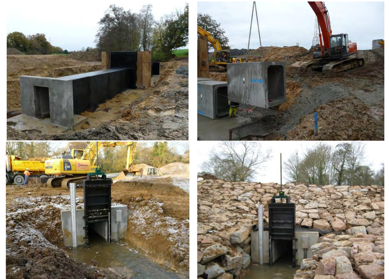
Photographies de réalisation cadre béton en traversée de digue équipé d'une vanne murale manuelle
