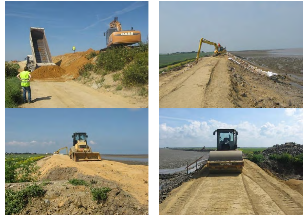
Photographies d'édification d'une digue de protection
