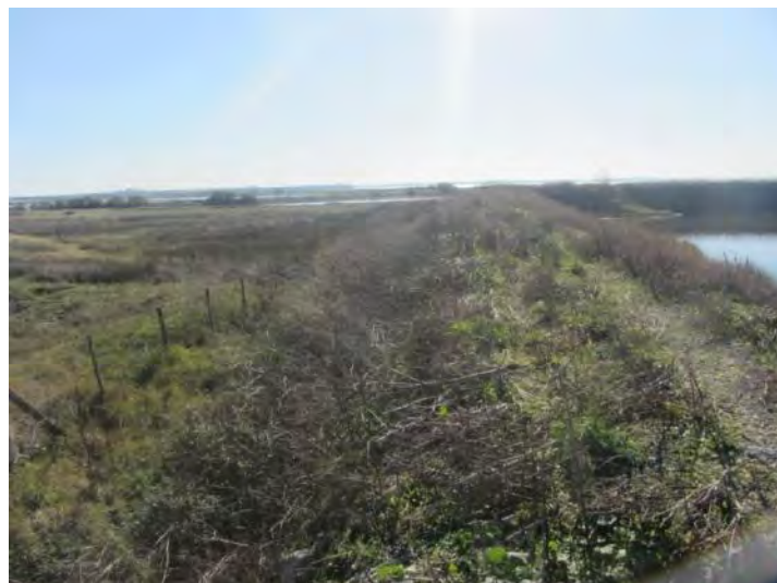
Vue sur la digue en retour vers l'est à l'intérieur de la réserve (remblais en pente repris après Xynthia) formant l'enceinte de la zone SACOM, prise vers l'ouest
