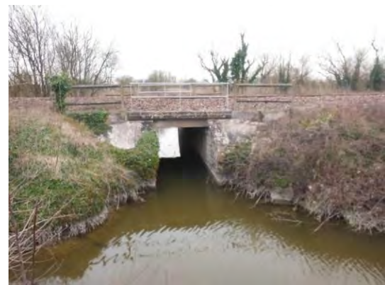
Vue sur l'ouvrage SNCF
