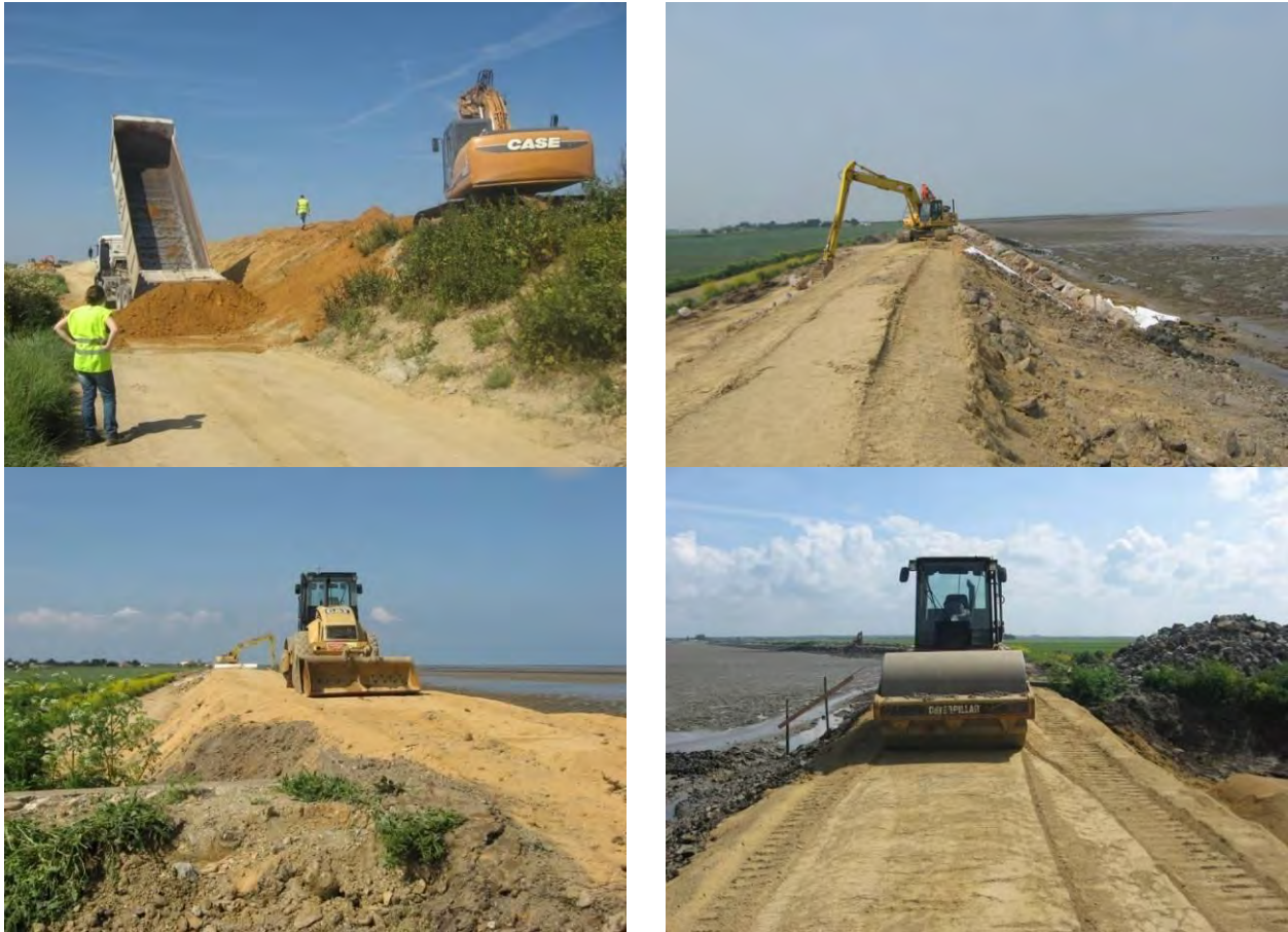
Figure 77 : photographies d'édification d'une digue de protection
