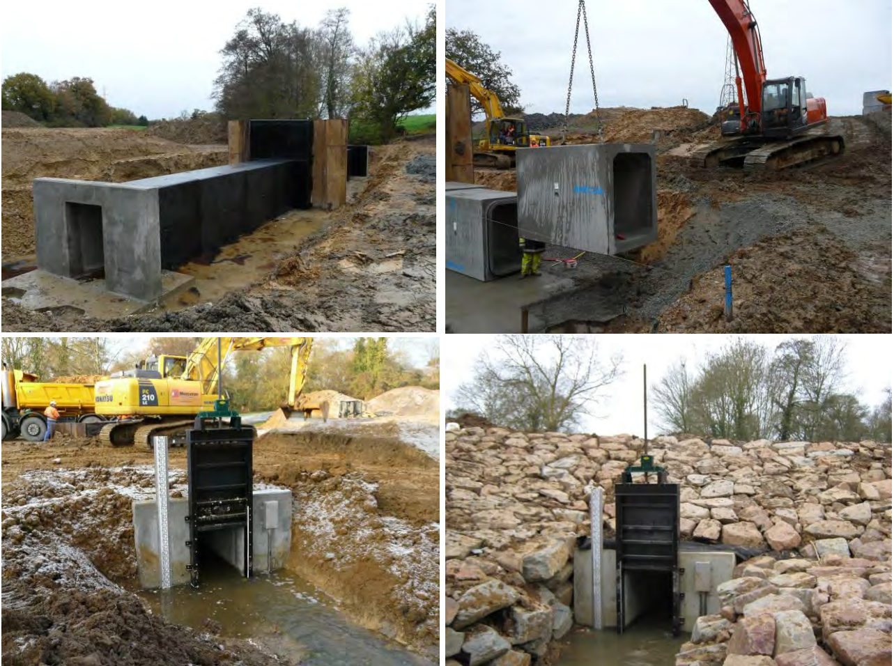
Figure 81 : Photographies de réalisation cadre béton en traversée de digue équipé d'une vanne murale manuelle
