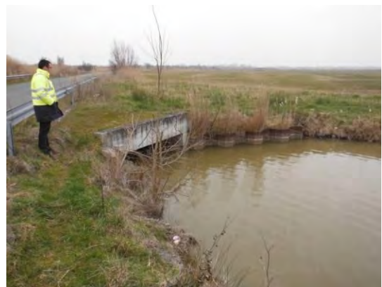
Vue sur l'ouvrage routier
