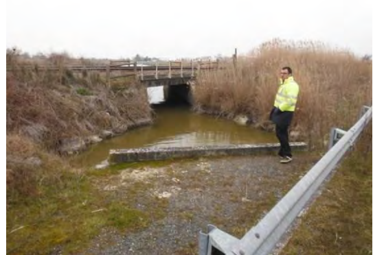
Vue sur l'ouvrage SNCF
