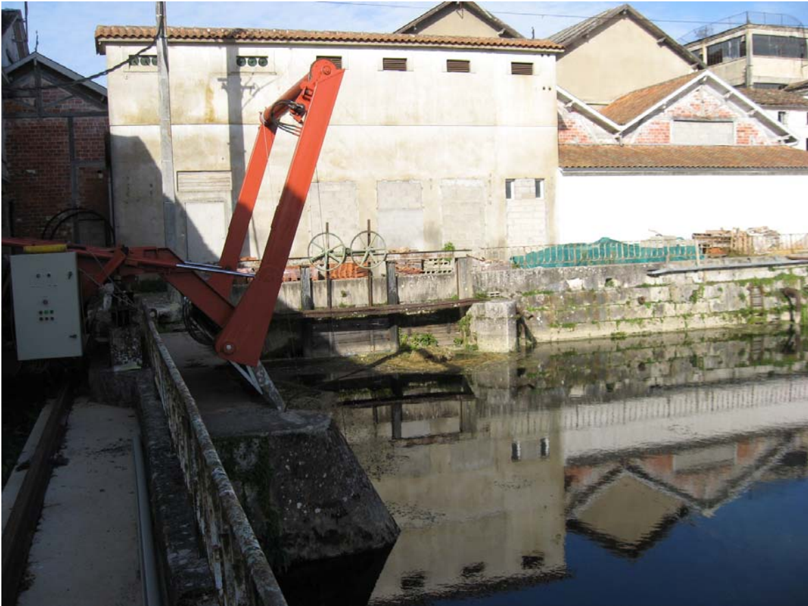
Figure 1 - Vue de l'écluse, de l'île et de la vanne de décharge à Sireuil
