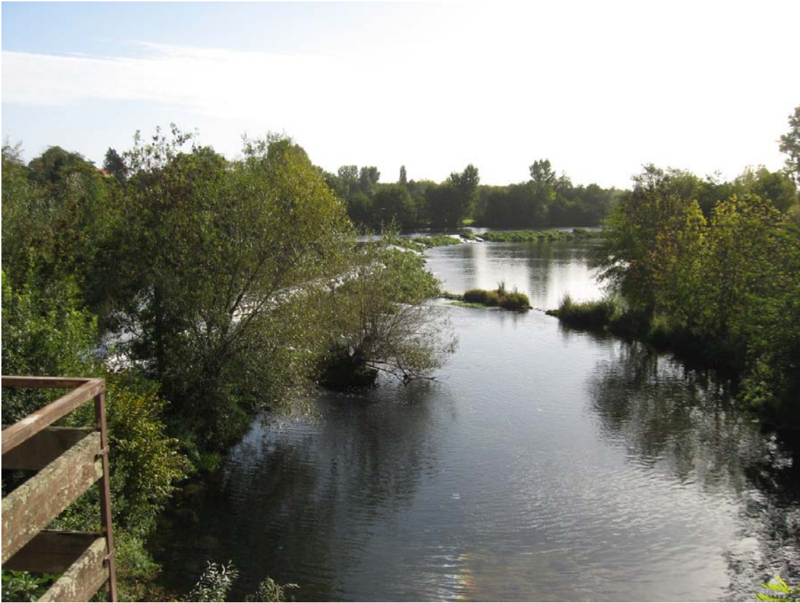
Figure 5 - Vue du déversoir_Usine de Sireuil
