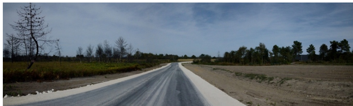
Vue depuis la voie de désenclavement de la Penotte (à gauche, les Brandes de Soyaux, à droite la parcelle nettoyée)
