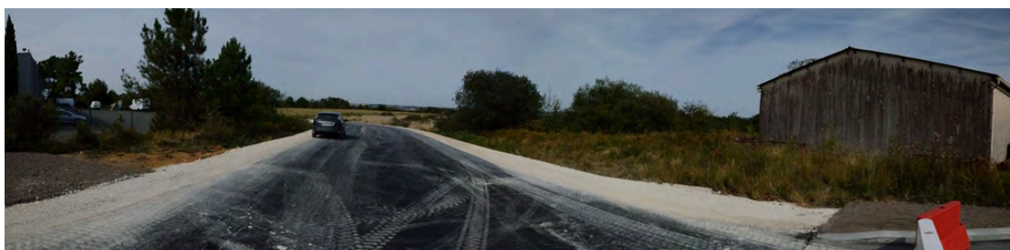
La connexion entre l'ancienne et la nouvelle voie
