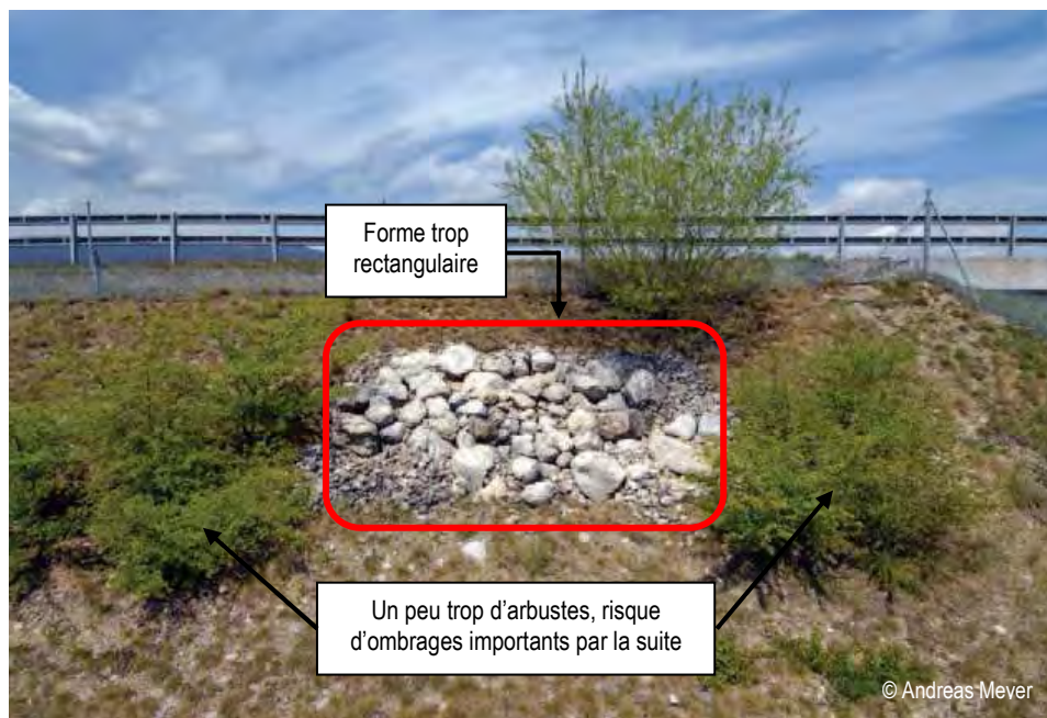
Figure 75 : Exemple n°2 de « niche pierreuse » mise en place sur un talus d'autoroute
