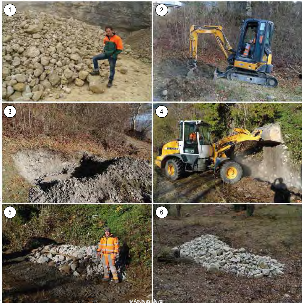
Figure 77 : Étapes de réalisation d'un « tas de pierres » pour les reptiles
