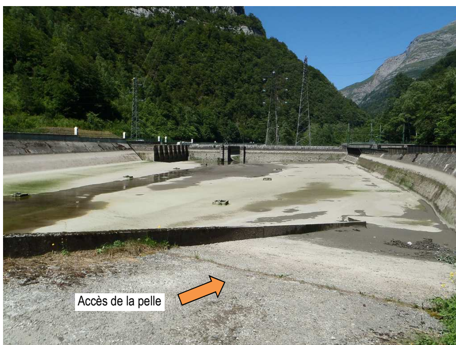
Figure 7 : Accès de la pelle au chantier
