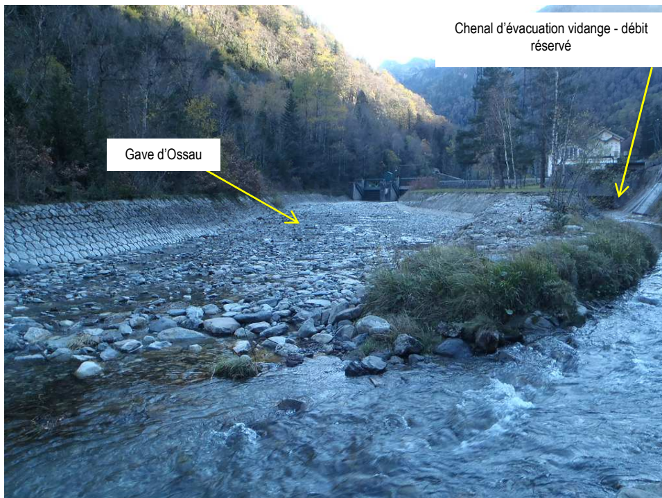
Figure 4 : Aval du bassin du Hourat (vue vers l'amont) – confluence
