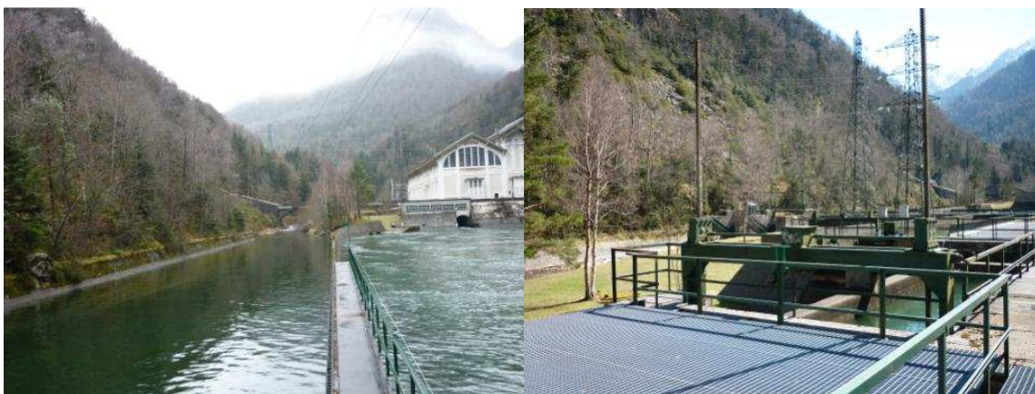
Figure 2 : Bassin de Miègebat et Prise d'eau du Hourat
