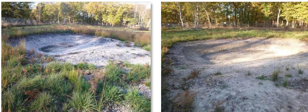
**Figure 20 : Mares en eau : à l'est et à l'ouest surcreusées (février 2017) de 10-20 cm pour atteindre le 1m préconisé initialement. - 16/11/2017**
