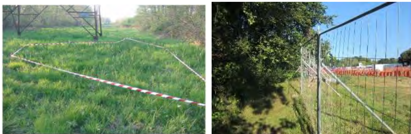
Figure 39 : Exemple de balisage ; Balisage de plante protégée en Sologne, préalable à des travaux sur pylône (gauche), Protection de haie dans le cadre de la création d'un tunnel (droite)
