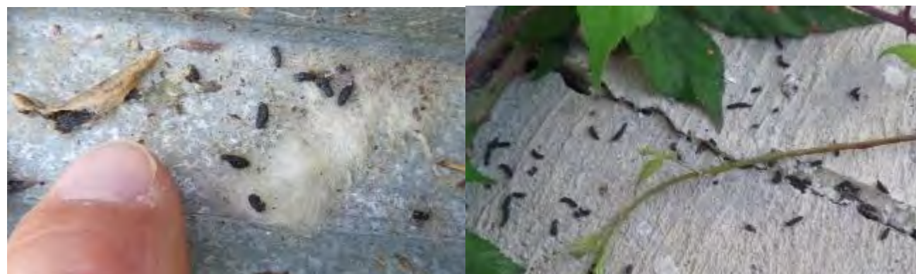
Figure 33 : Crottes de chiroptères, bâtiment 300, sous fissure
