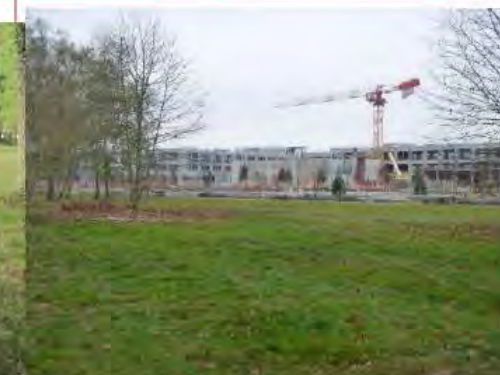
Pelouse sous emprises du parking (aménagement en cours Thalès en second plan), novembre 2015
