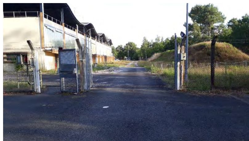
Bâtiment actuel sous emprises
