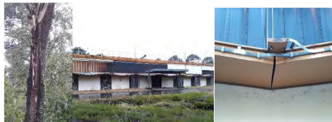
Figure 32 : Pin maritime avec trou de Pic épeiche, et arrière du bâtiment 300 avec fissure utilisée comme gîte
