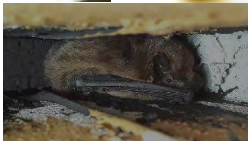
Figure 34 : Pipistrelle sp, bâtiment 300, août et septembre 2019 (fissure horizontale de 1,1 m de longueur, 11 cm de profondeur et 2,2 cm de largeur)
