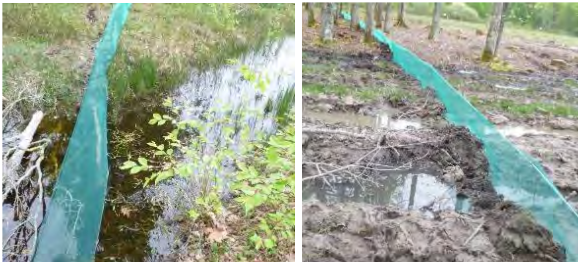
Figure 40 : Clôture anti-intrusion installée sur le site de Safran en avril 2016
