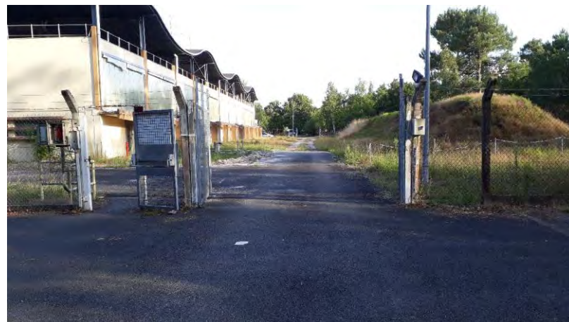
Bâtiment actuel sous emprises
