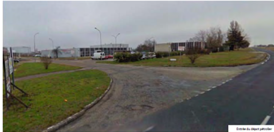
Figure 11 : Entrée de la canalisation sur le dépôt pétrolier, au niveau du tronçon 46 (Source CPIE Médoc)
