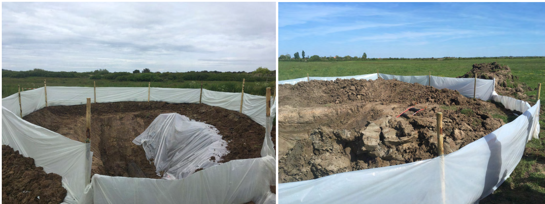
Figure 22 : photographies de barrière petite faune au droit de la zone de fouille (Source AECOM)
