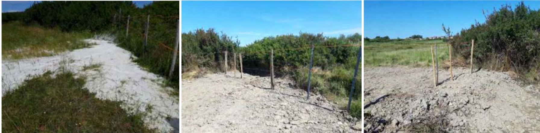
Figure 24 : photographies du déversement de béton dans le fossé (Source CPIE Médoc)
