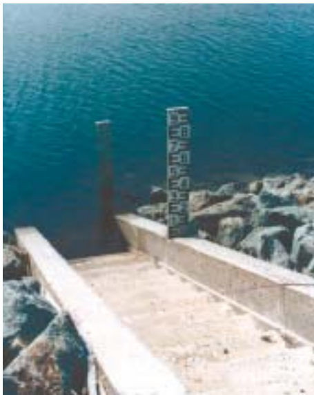
Photo 2. Échelle limnimétrique posée sur le parement amont (barrage d'Alzitone, Corse).
