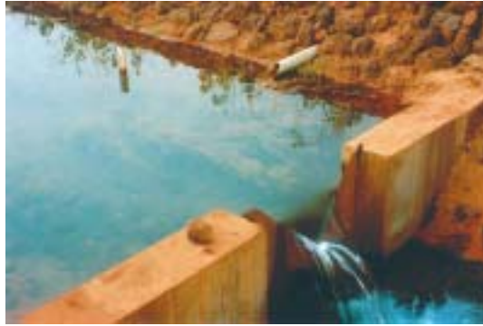
Photos 4a. Seuil calibré triangulaire pour mesure des débits, équipé de son limnimètre amont (barrage de Douma, Burkina Faso).
