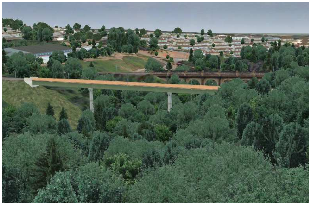
Ouvrage de franchissement du ruisseau du Palais (extrait de la maquette numérique du projet)
