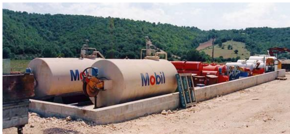
En phase travaux, mise en place de bacs étanches pour éviter les fuites accidentelles dans les zones sensibles (source Egis environnement)
