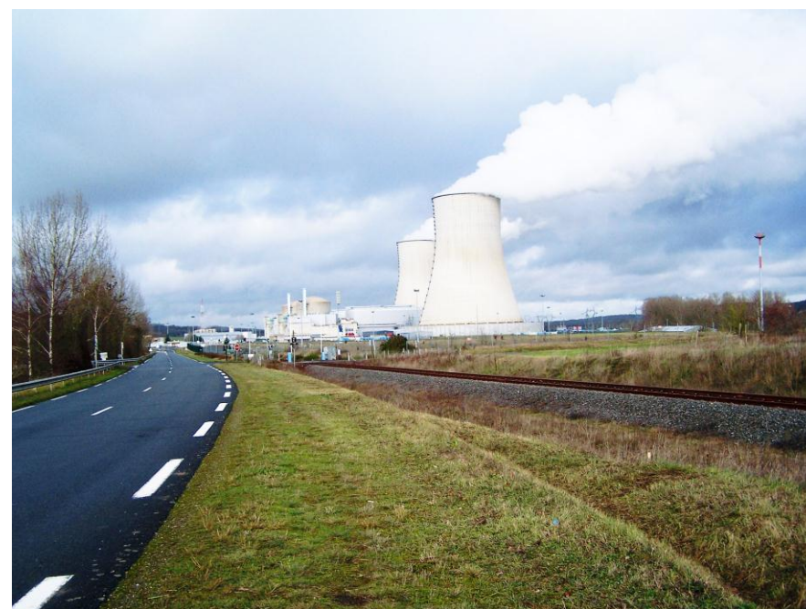
Centrale nucléaire de Civaux (photo Egis Environnement – décembre 2008)
