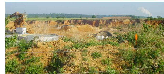
Les carrières, rive gauche de la Vienne (source Egis Rail – 2010)
