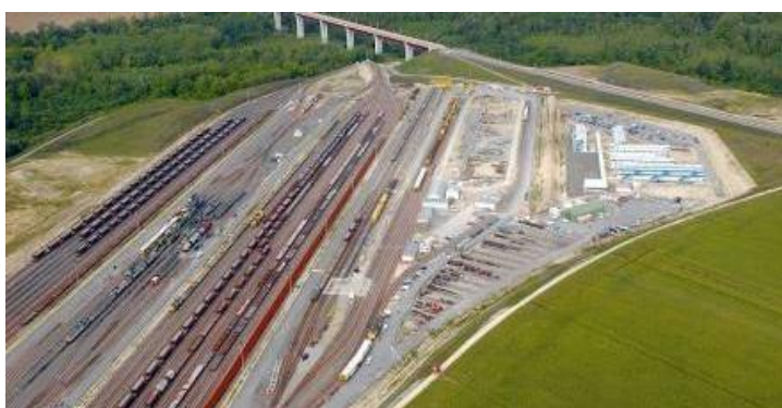
Exemple : base travaux d'Ocquerre – LGV Est (RFF / CAPA / Laurent Rothan (TOMA))
