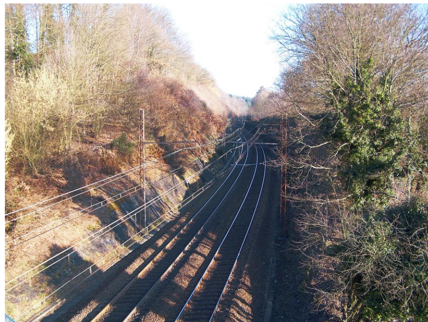
Voie ferrée Paris – Limoges – Toulouse au niveau du Palais-sur-Vienne (photo Egis Environnement – février 2009)
