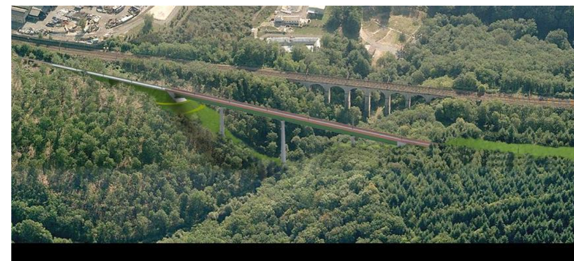
Viaduc du Palais (commune du Palais-sur-Vienne) - Source : JMI
