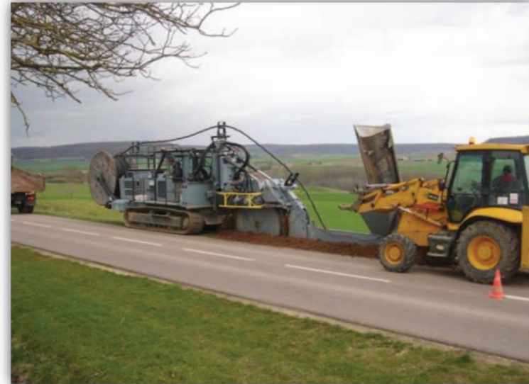
Réalisation d'une tranchée d'enfouissement des câbles de raccordement au réseau public de distribution d'électricité
