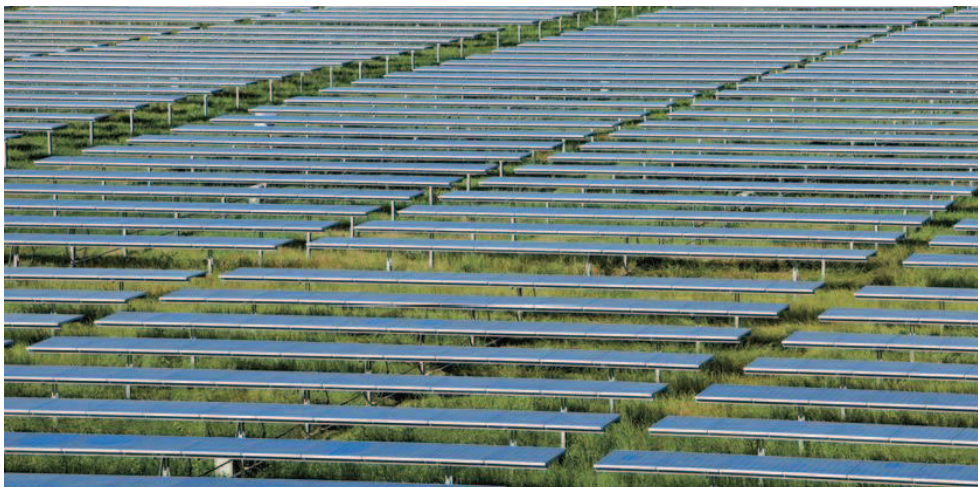
Le tracker est un tracker horizontal à un axe.
