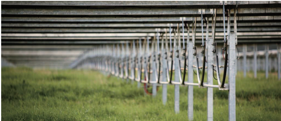
Le tracker est un tracker horizontal à un axe.
