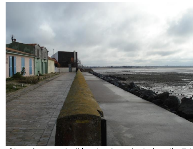
Cheminement allée des Bouchots (partie Est)
