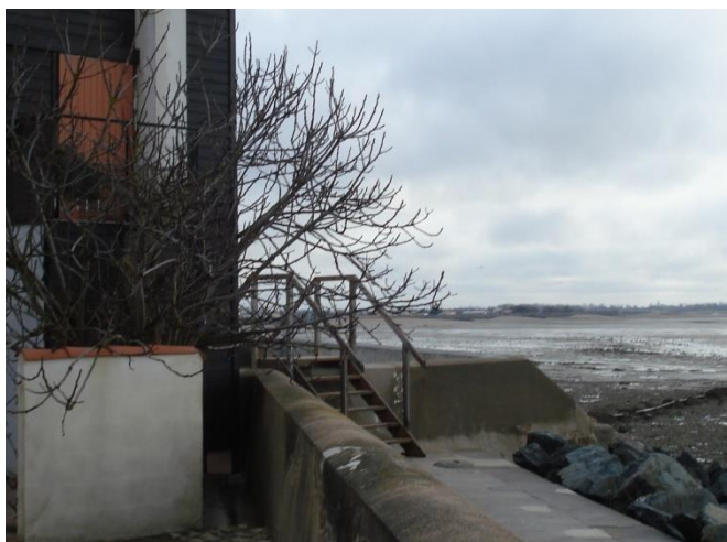
Passage en escalier impossible pour les PMR
