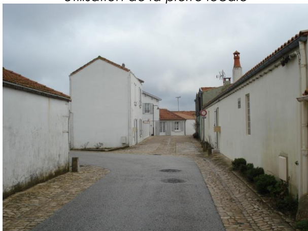
Utilisation de la pierre pour les caniveaux latéraux réduisant ainsi visuellement la largeur de la chaussée et permettant de ralentir la circulation
