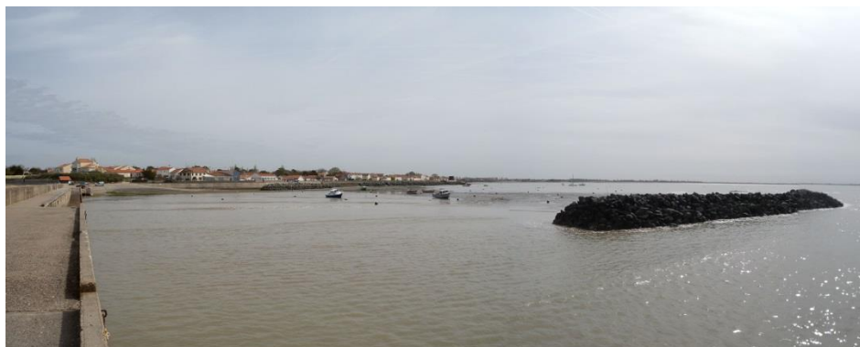
Vue sur le brise-lame existant
