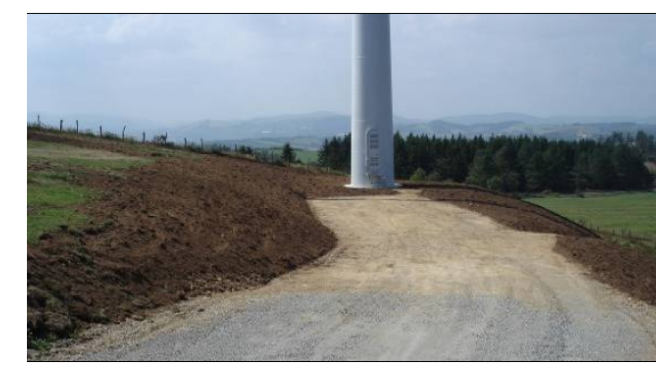
Plateforme de levage restaurée en fin de chantier
