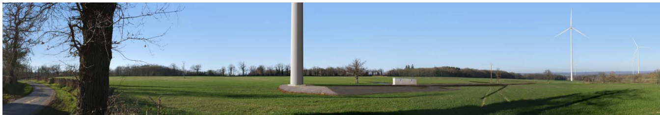
Photomontage d'une partie du projet (éoliennes E5, E4, E2 et E1) en perception immédiate
