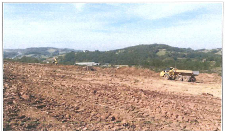
Travaux de terrassement en septembre 2014 (illustration issue du dossier)
