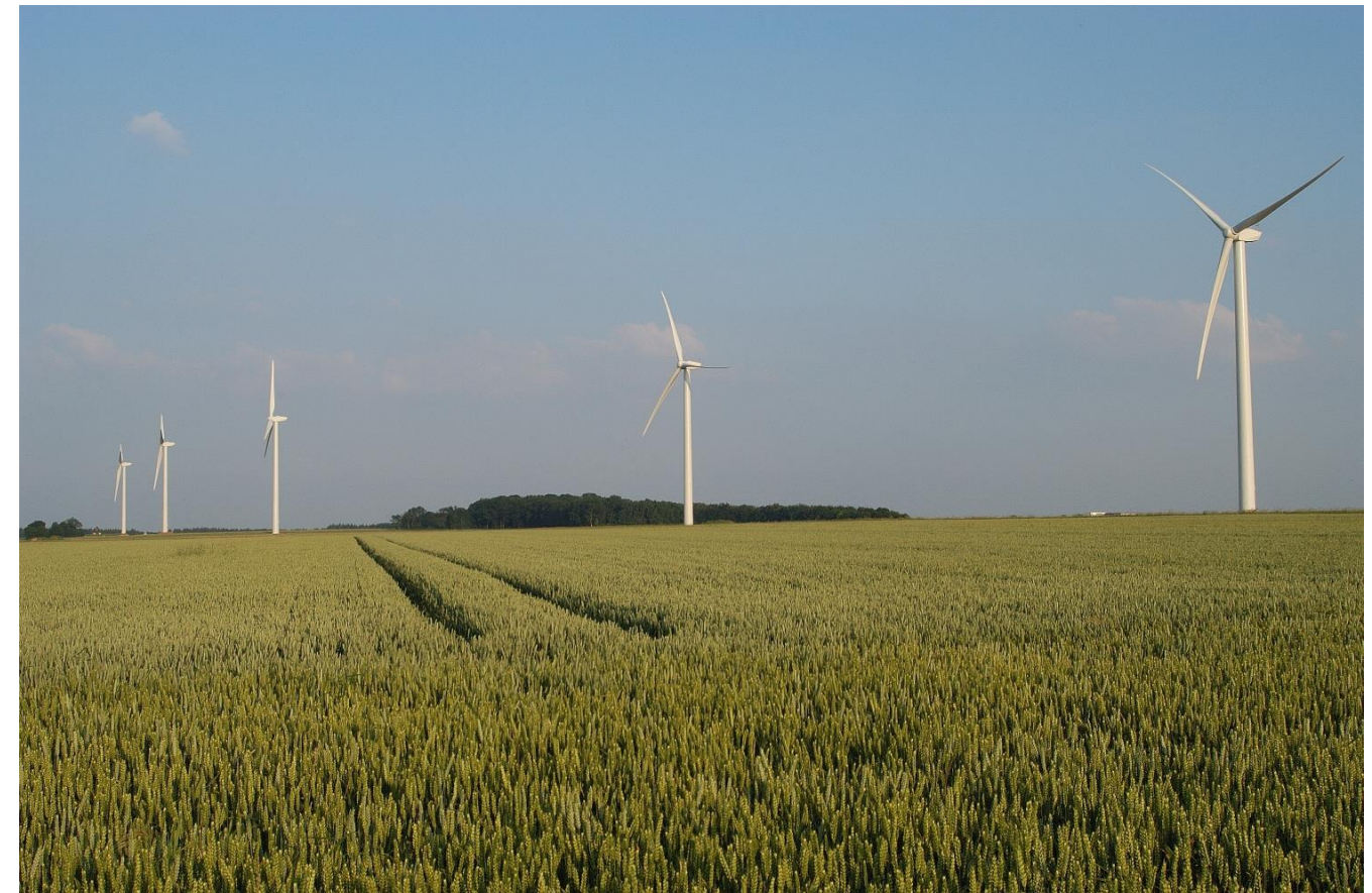
Vue générale d'un parc éolien en plaine (Source : VALOREM)
