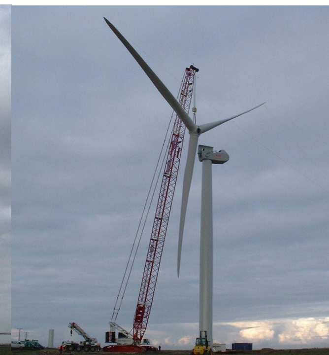
Montage du rotor
