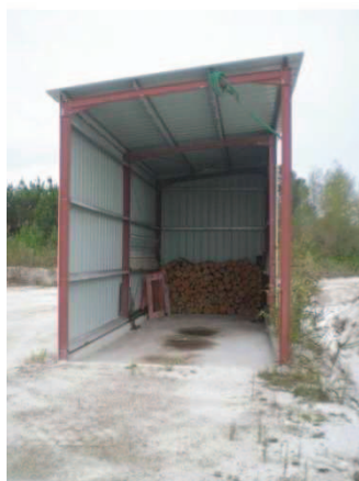
Aire étanche pour le ravitaillement des engins
