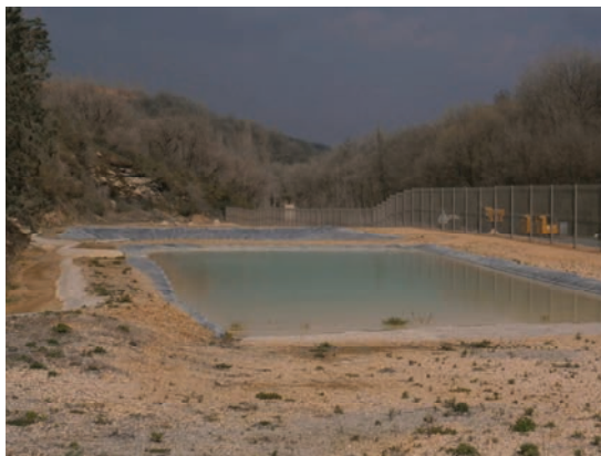
Exemple de bassin de décantation
