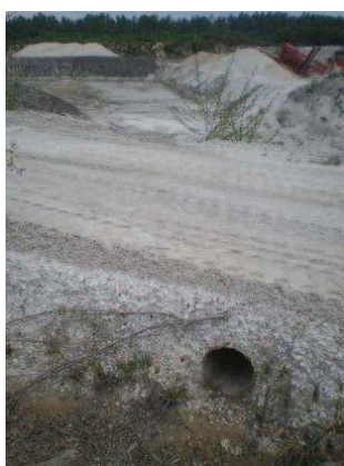
Canalisation des eaux pluviales
