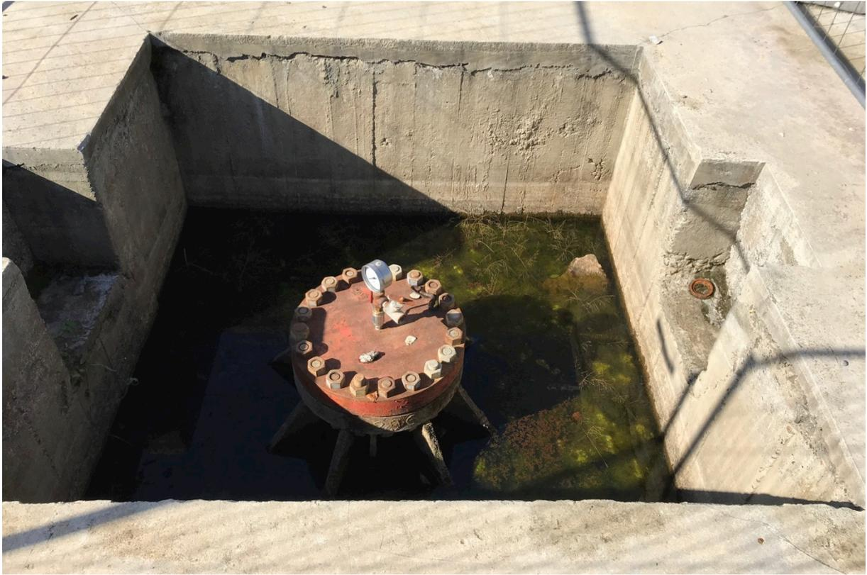
photo.5: vue de la tête de puits. Ces ouvrages sont des pièges pour les batraciens en offrant aucun dispositif de sortie.
