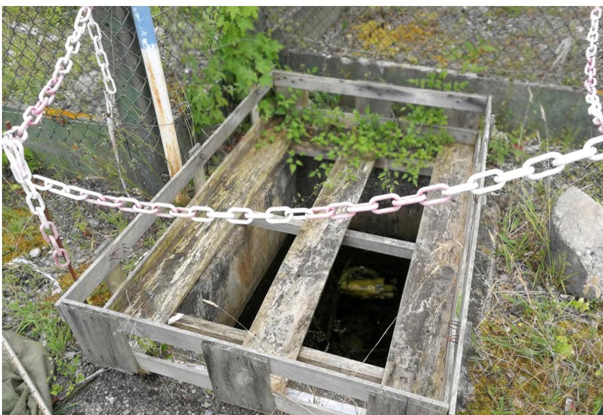
photo.3: vue D'un ouvrage hydraulique. Ce type d'ouvrage ne présente aucune possibilité de sortie aux batraciens.
