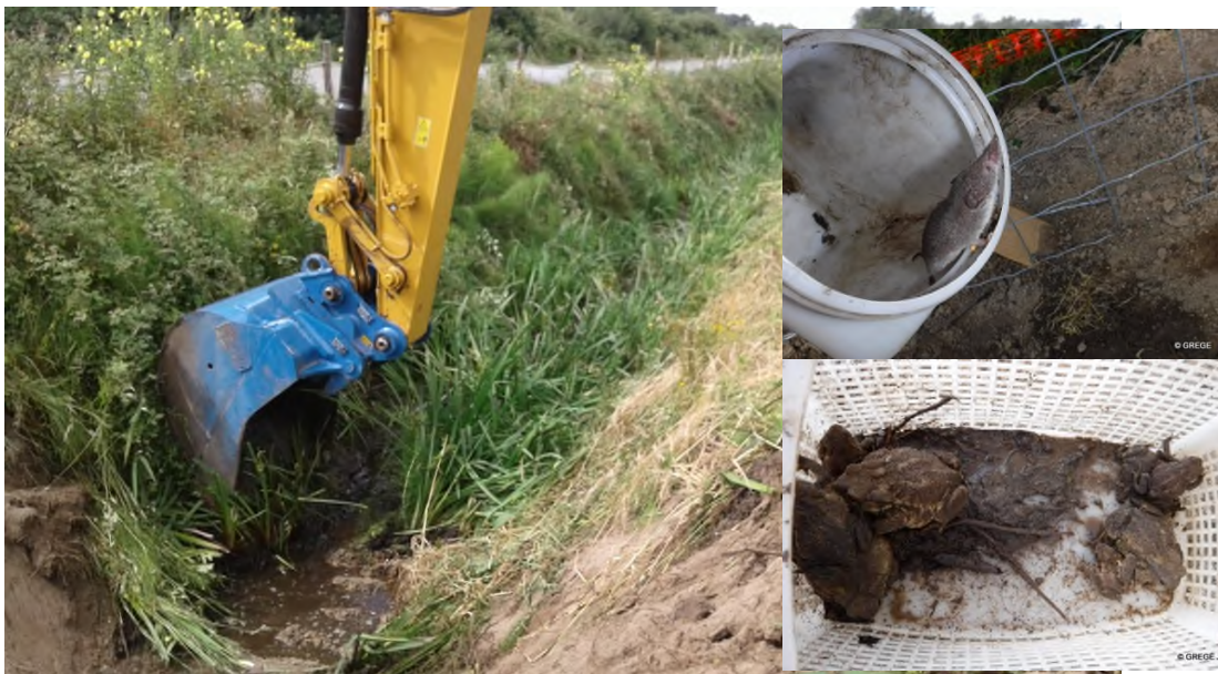
Fig.5: mise en œuvre des techniques de griffage
