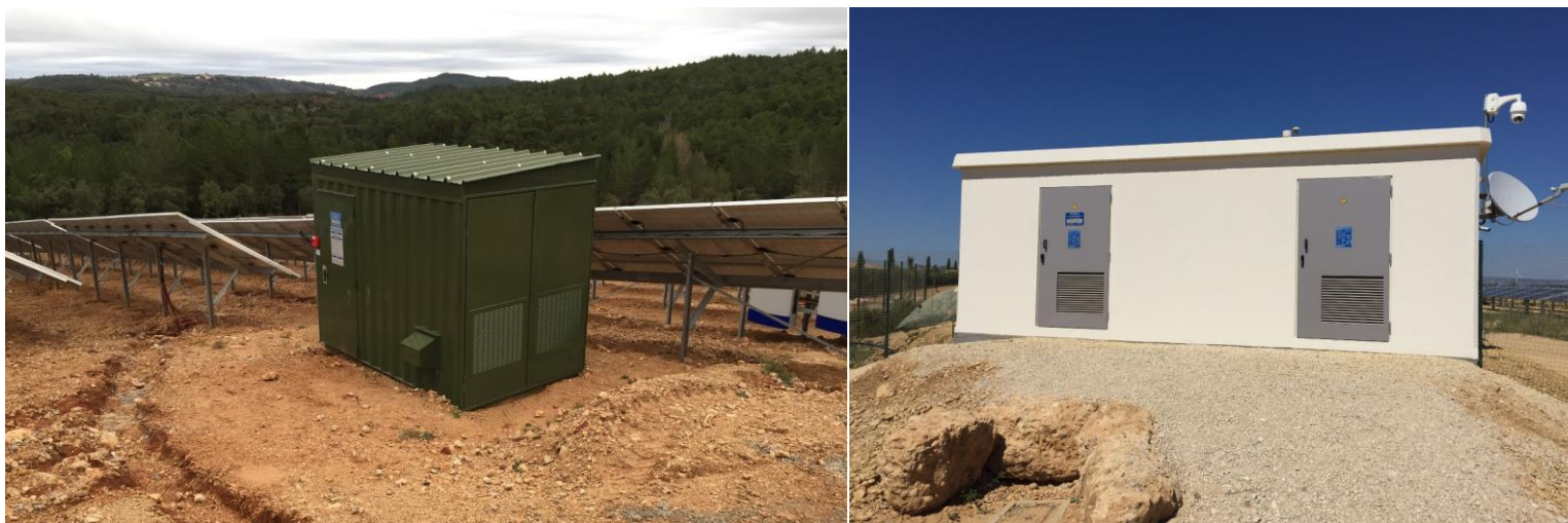
Fig. 11. Exemple d'un poste de transformation à gauche et d'un poste de livraison à droite
