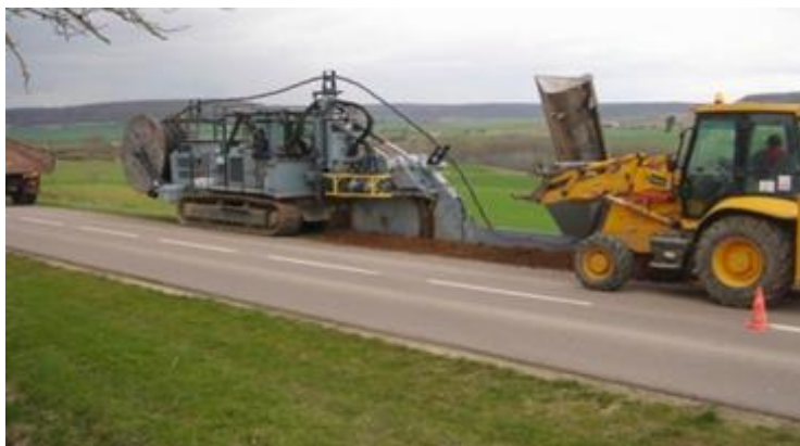
Fig. 17. Trancheurs et raccordement
