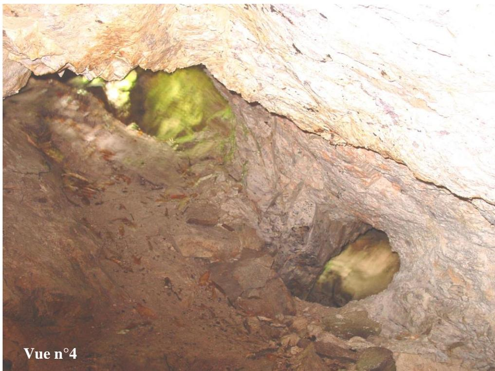
Photo n°14. Pilier de roche conservé au centre de la cavité
