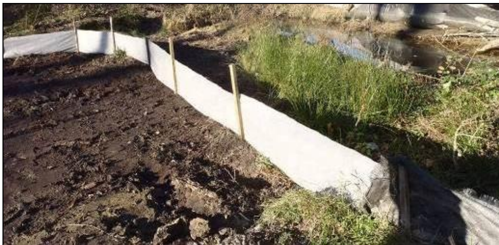
Implantation de barrières anti-amphibiens en géotextile permettant d'éviter les déplacements des individus vers le chantier © ETEN Environnement
