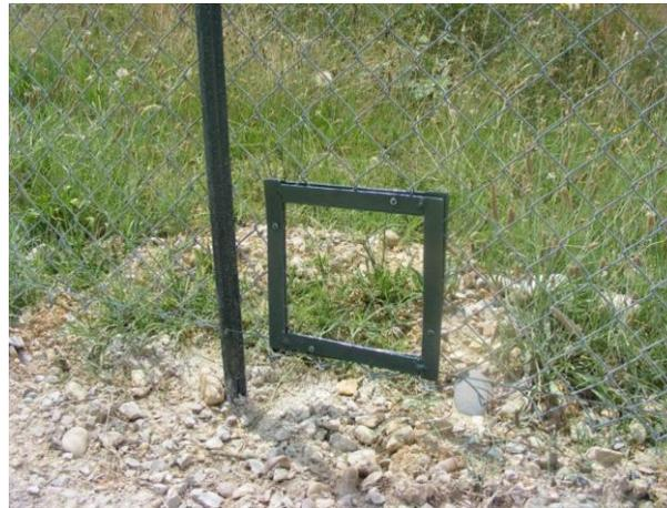
**Fig. 47. Exemple d'une trappe pour la petite faune**
