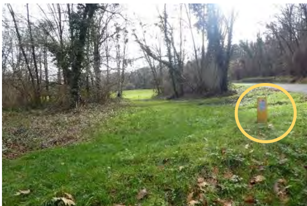
Figure 6 : Bornes et balises indiquant la présence de la canalisation enterrée
