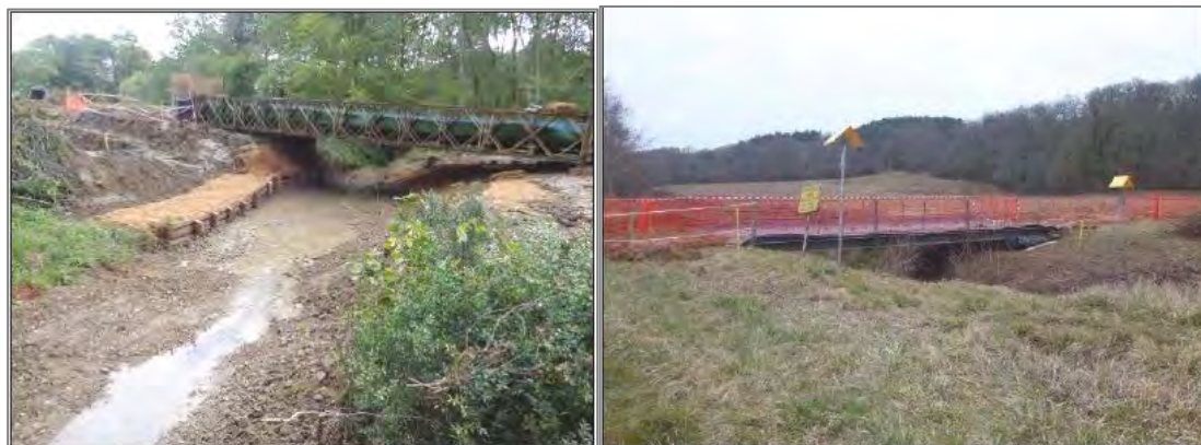
A gauche : pont du génie civil/pont Bailey (Source : Chantier Artère de l'Adour), à droite : pont composé d'un assemblage de plusieurs structures métalliques (Source : chantier Artère du Béarn)
