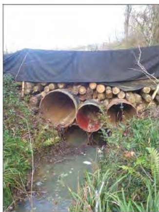
Figure 8 : Gainés métalliques recouvertes d'un platelage en rondins de bois (photo : TEREGA)
