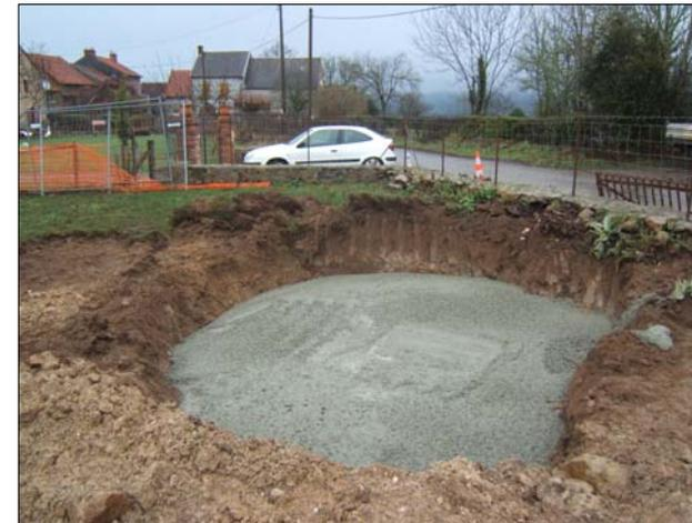
Coulage du bouchon en béton armé (12 m<sup>3</sup>)
