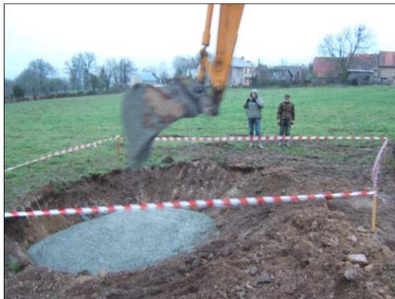
Coulage du bouchon en béton (6 m<sup>3</sup>)
