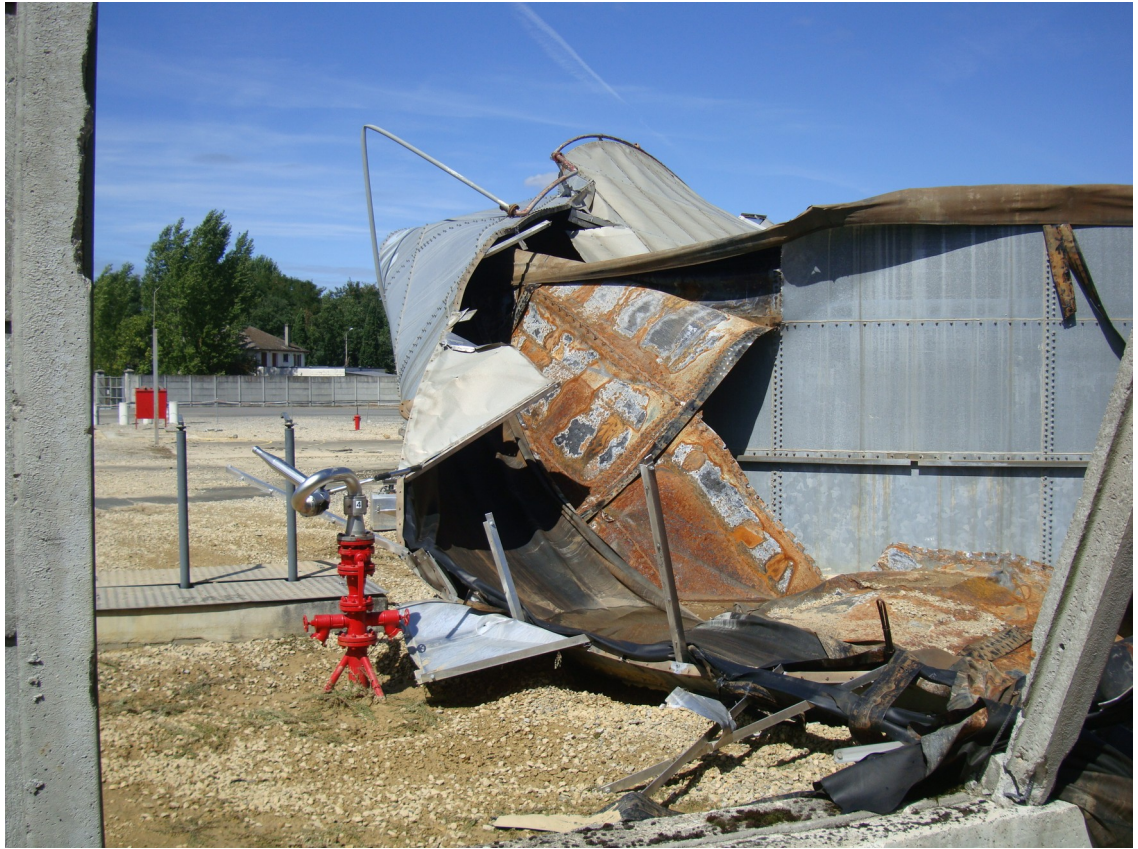
Rupture de la réserve d'eau d'incendie
