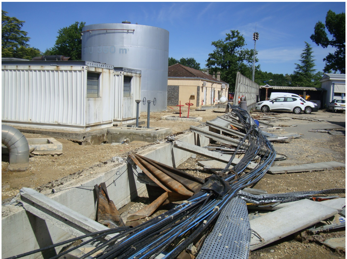
Effets de la vague d'eau sur les clôtures et installations voisines
