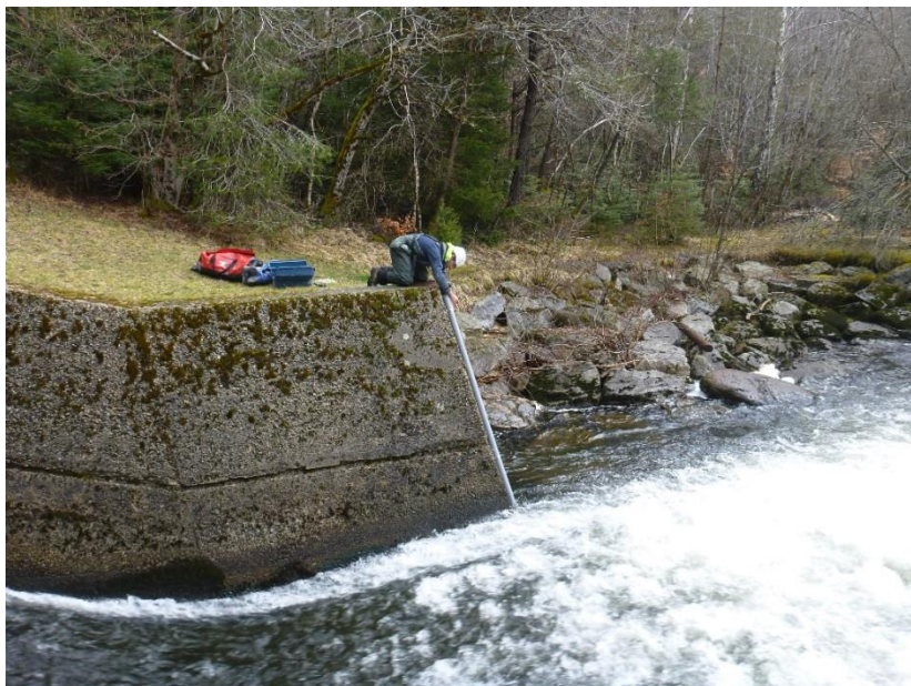
Figure 6 : Installation en place à l'entrée du lac de la Crégut (Source : ATHOS Environnement)
