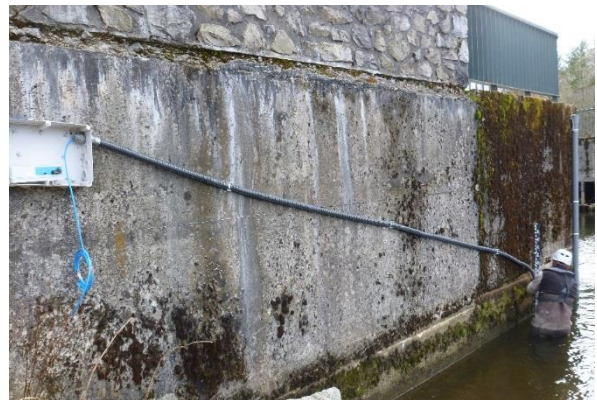
Figure 3 : Capteur de niveau d'eau de la station sortie Lac (à droite) / déchargement de l'enregistreur (à gauche) (Source : ATHOS Environnement)
