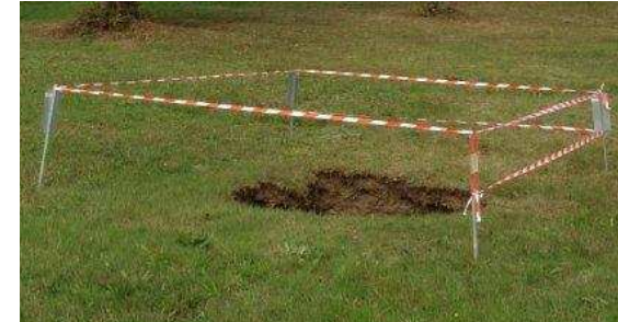
Affaissement mis en sécurité par la Mairie d'Egletons le 12/10/2012
