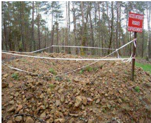
Affaissement de la tête du puits constaté en janvier 2012
