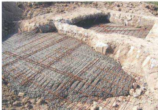
Pose du treillis soudé
