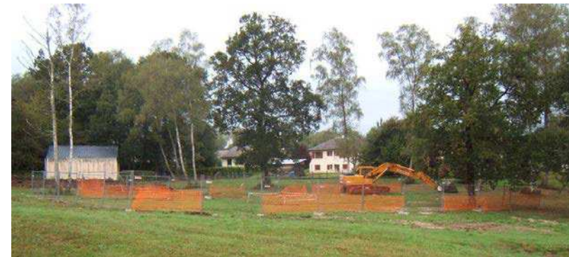
Mise en place d'un périmètre de sécurité provisoire autour de l'ensemble de la zone susceptible de s'affaisser (aplomb des TMS proche de la surface)
