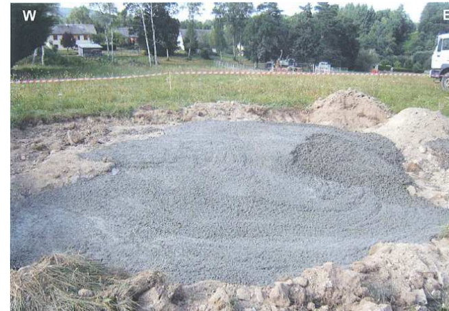
Coulage seconde toupie ( 16m 3 béton à 250 Kg)
