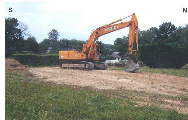
Mise en place des matériaux de couverture
