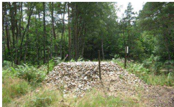
Tête du puits rechargé en juillet 2012
