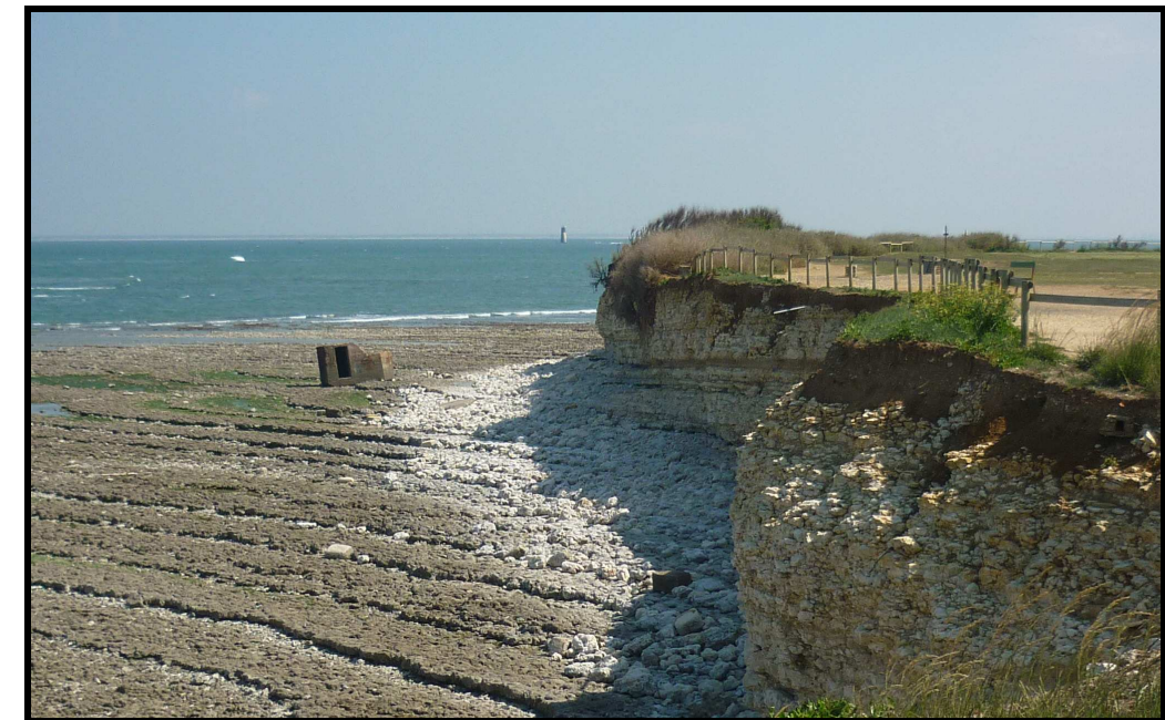
Figure 3 - Érosion / Recul de falaise à Saint Denis d'Oléron lors de la tempête Xynthia
