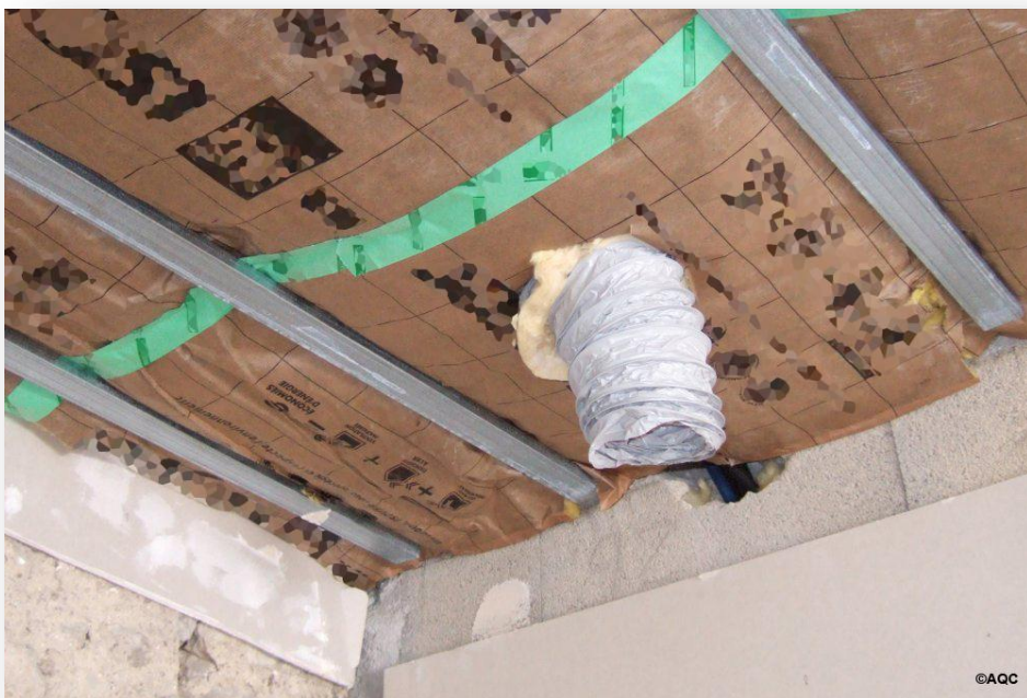
Étanchéité à l'air
