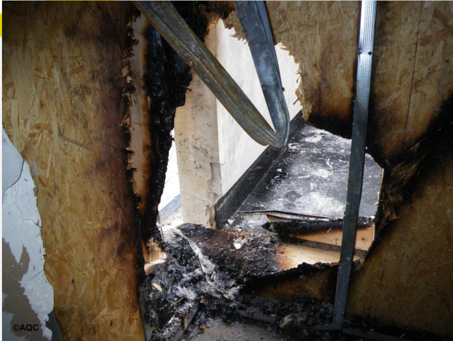
Incendie cours chantier
