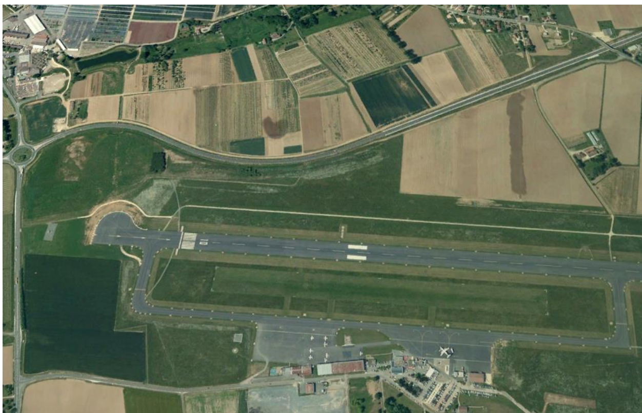
Mise en culture d'une grande partie des terrains du projet lors des 15 dernières années (photographie aérienne d'archives datant de décembre 2005)
