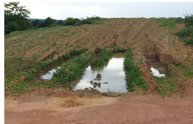
Ornière d'engin de chantier
