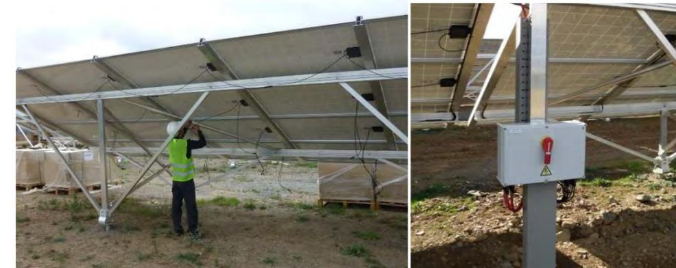
A gauche : Câblage des panneaux – A droite : Boîtier de raccordement - RES
