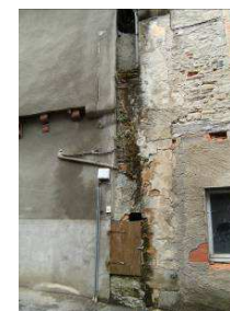
Les « andrones » sont de petits espaces ménagés entre les maisons et destinés à recevoir les eaux de pluie ainsi que les égouts. Ils constituent des témoignages importants de l'organisation urbaine de la ville médiévale.
