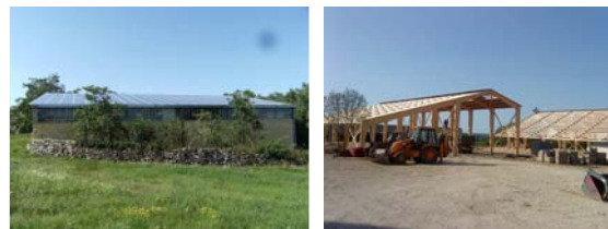
Exemples de bâtiments agricoles, supports de panneaux photovoltaïques bien intégrés du fait de leurs dimensions conformes à celle du bâti agricole présent sur le territoire de Ligneyrac, à l'équilibre des versants. A noter l'intégration des panneaux du fait de l'harmonisation de leur couleur avec celle du support de couverture.
