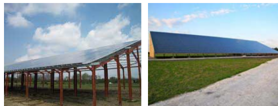
Exemples de bâtiments agricoles, supports de panneaux photovoltaïques mal intégrés du fait de leurs dimensions excessives et de leur monopente.
