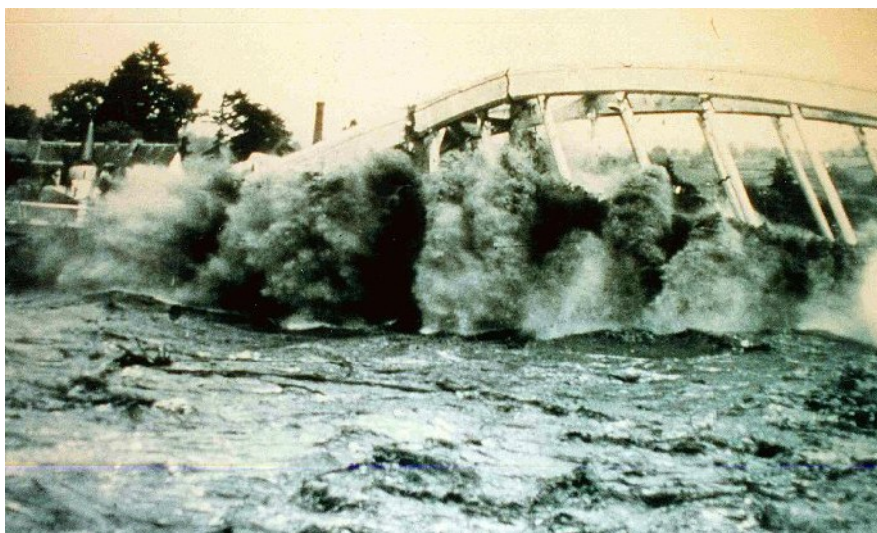
Crue de la Loire du 21 septembre 1980, effondrement du pont de Coubon sur la Loire, à l'amont de Brives Charensac, (auteur : Roland Galien)
