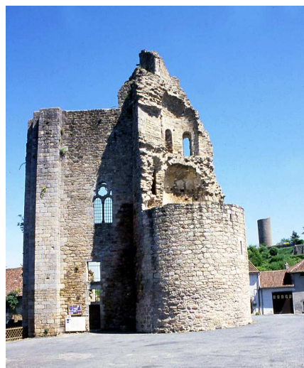
Le donjon après l'effondrement de 1994. En arrière-plan, le donjon se Châlus-Chabrol
