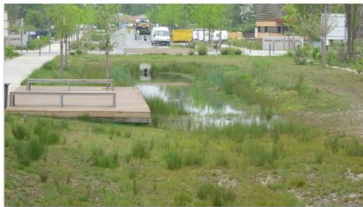
Noues récemment créée au niveau de l'opération Vert Castel 1 en bordure immédiate du site accueillant des amphibiens protégés, dans plantes et habitats remarquables ( Menyanthes trifoliata , végétation amphibie oligotrophe à Scirpus fluitans , Juncus bulbosus ), et une libellule déterminante en Aquitaine ( Ischnura pumilio ).
