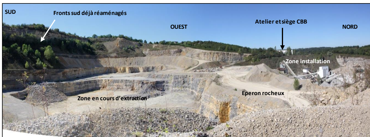
Figure 3 : Vue sur la carrière actuelle depuis l'est
