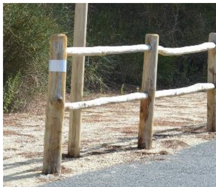
Modèle double lice avec lice horizontale non cylindrée
