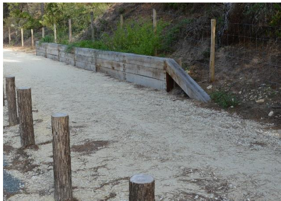
Le sentier piétons en calcaire stabilisé
