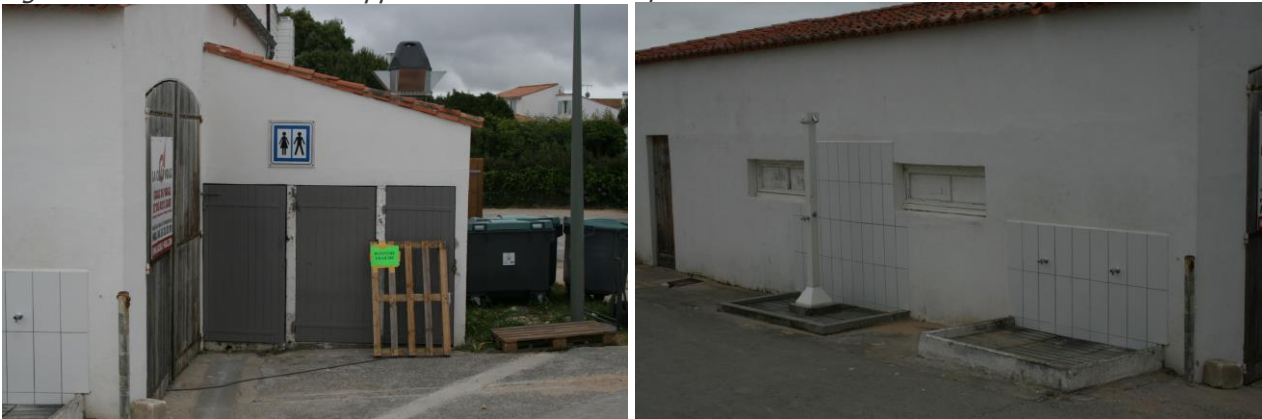
Figure 4 : Vues des sanitaires et de la douche
