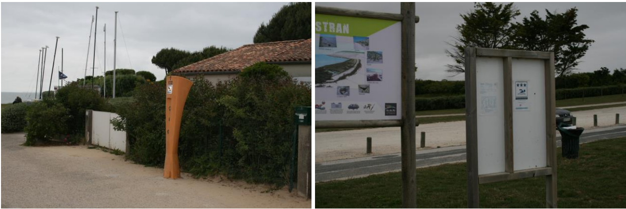
Figure 3 : Vues de la borne d'appel des secours et des panneaux d'information
