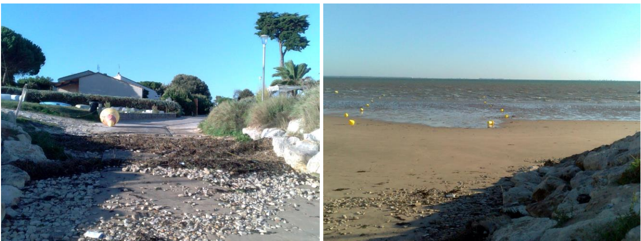
Figure 2: Vues de la cale de mise à l'eau et du chenal de navigation
