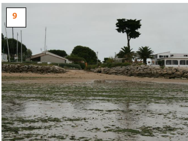
Figure 9 : Vue de la cale de mise à l'eau
